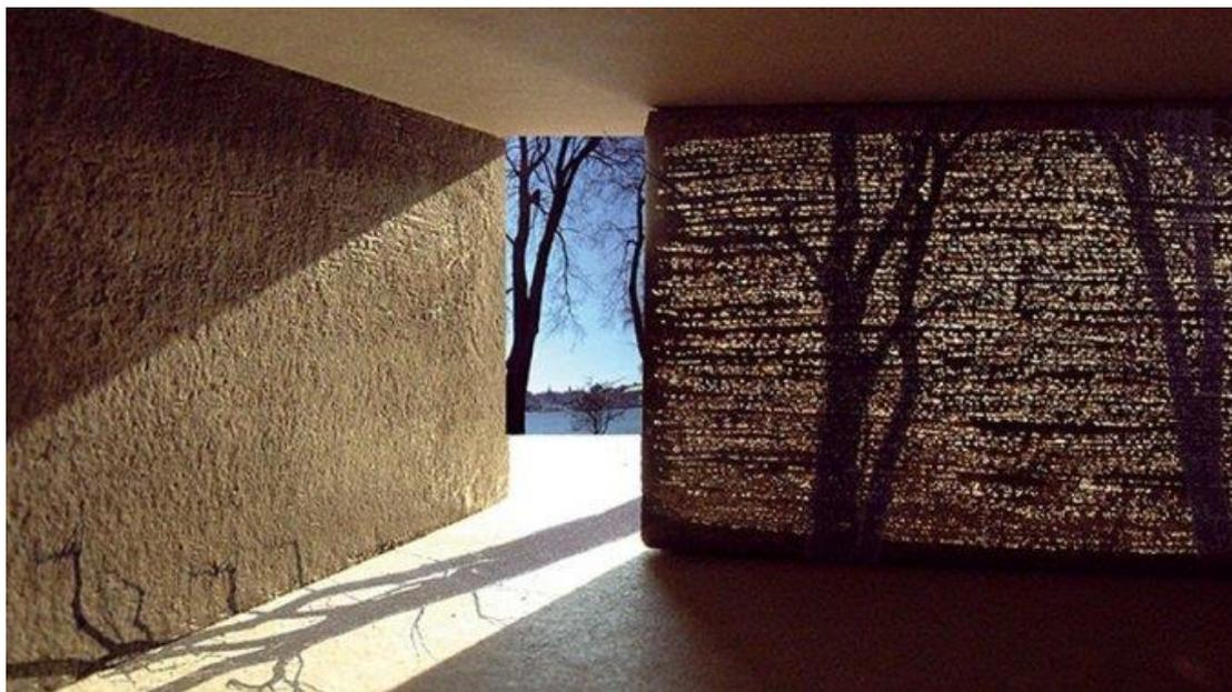
Заха Хадид использовала светопроводящий бетон при проектировании здания концерна BMW в Лейпциге. В Японии и Швеции построили сооружения с этим материалом. В США же есть мнение, что литракон за счет свойства полупрозрачности может быть вполне сносной оградой для правительственных зданий: ни один шпион не скроется.
